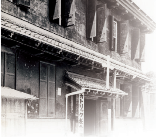
昭和29年に撮影された黒壁の建物。当時は長浜カトリック教会だった
